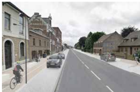
Des axes linéaires accueillant les modes doux (Rue des Fusillés à Villeneuve d'Ascq)
