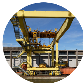
Portique du manutention du Port Loos - Sequedin
